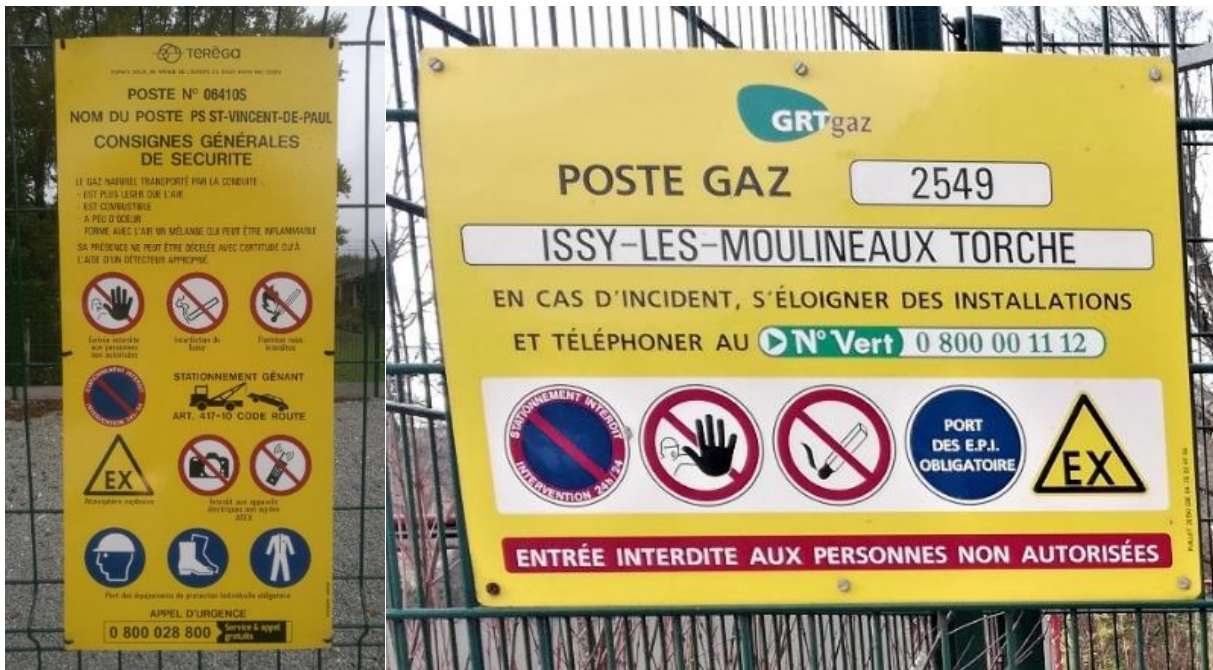
Plaques signalétiques de poste © Teréga et Christophe Perdriset – DGSCGC
