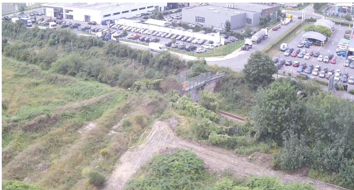
La fuite de gaz enflammée est située au niveau du pont, sans le bruit il est difficile de la localiser © SDIS 95
