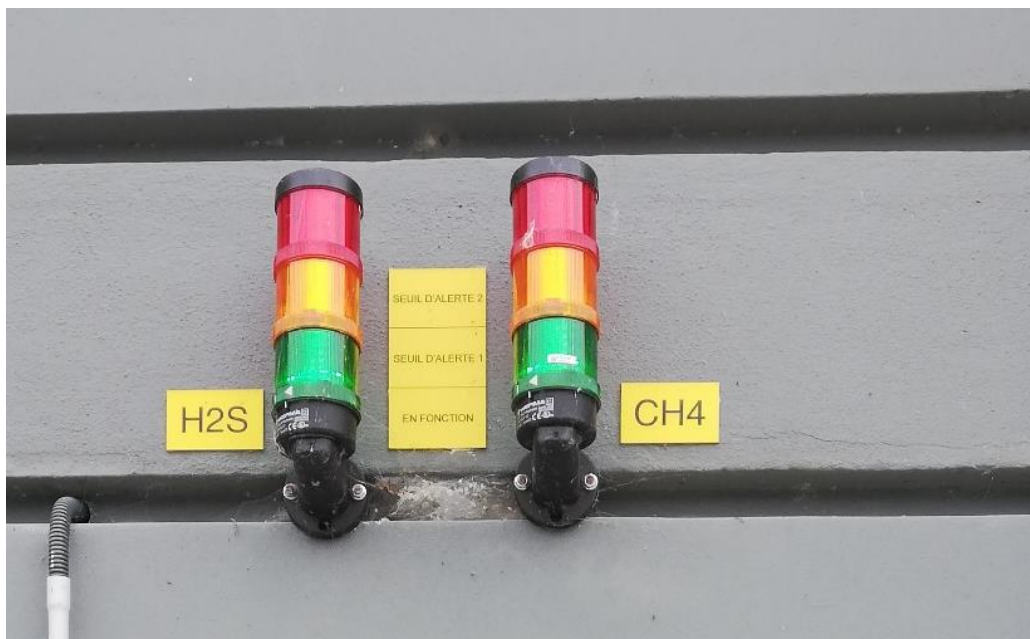
Voyants lumineux des seuils d'alerte (H 2 S et CH 4 ) situés à l'extérieur d'une station d'assainissement © Christophe Perdriset - DGSCGC
