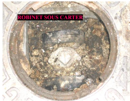
Organe de coupure générale sous carter © GRDF
