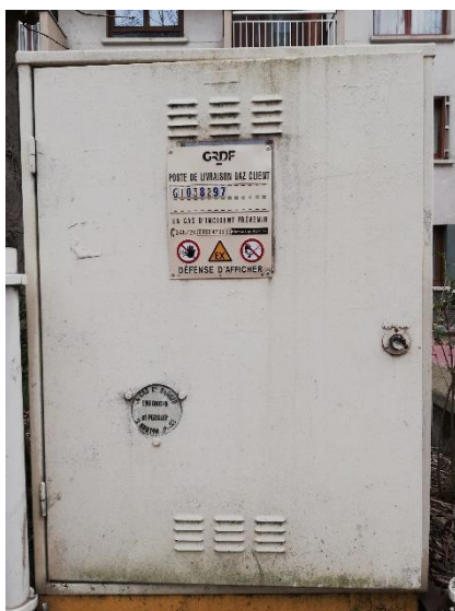
Poste GRDF de livraison gaz CLIENT , les sapeurs-pompiers peuvent couper le gaz, il y a un organe de coupure générale accessible depuis la voie publique. © Christophe Perdriset – DGSCGC
