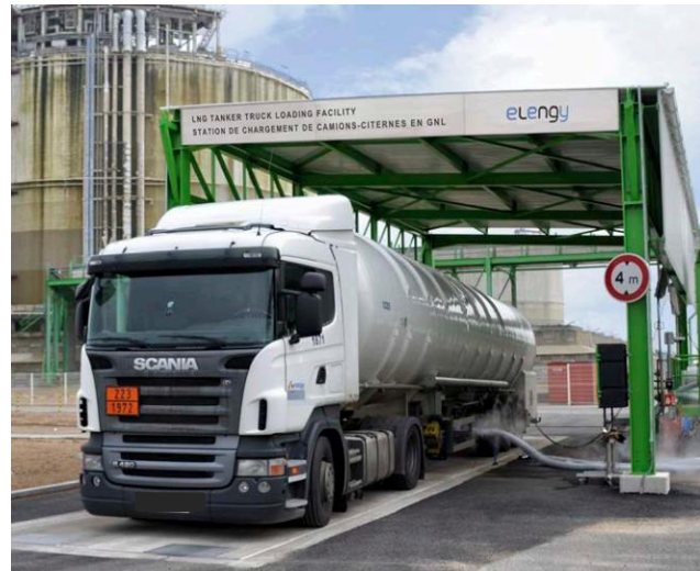
Opération de chargement d'un camion-citerne au terminal méthanier de Montoir-de-Bretagne © Elengy
