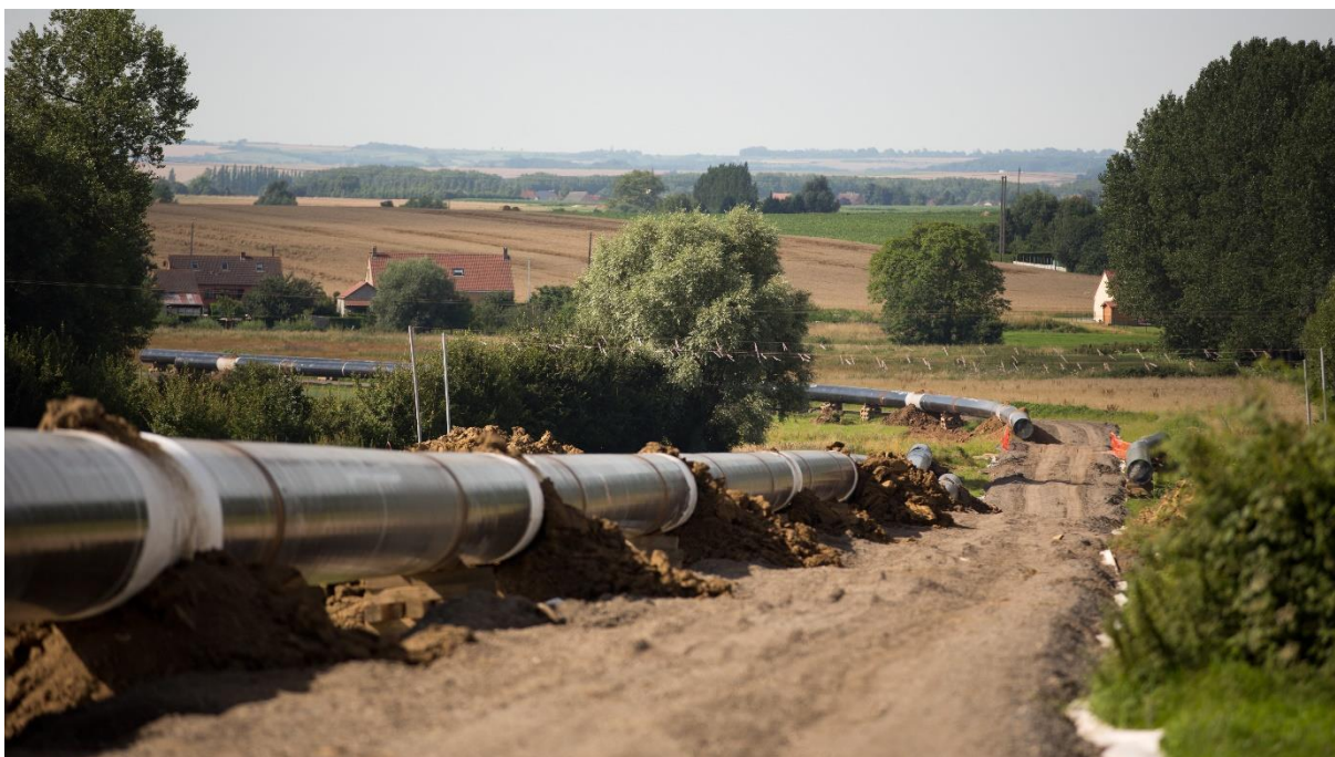
Tubes de canalisation soudés en attente d'enfouissement © GRTgaz
