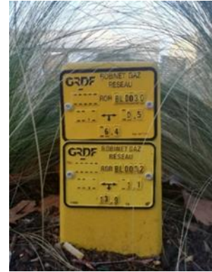
Borne signalant la présence d'un robinet gaz du réseau GRDF © Christophe Perdrisot – DGSCGC
