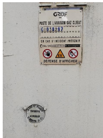
Poste GRDF de livraison gaz CLIENT , les sapeurs-pompiers peuvent couper le gaz, il y a un organe de coupure générale accessible depuis la voie publique. © Christophe Perdriset – DGSCGC
