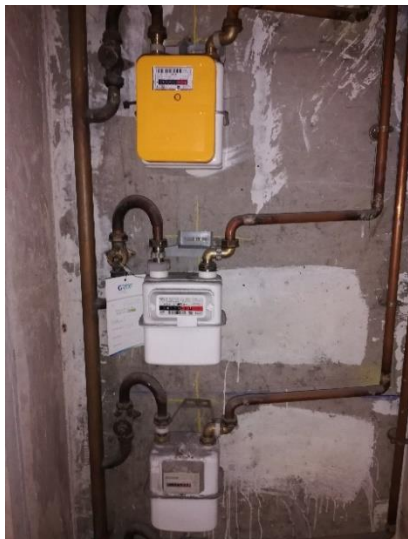
Compteurs individuels situés sur le palier d'un immeuble
