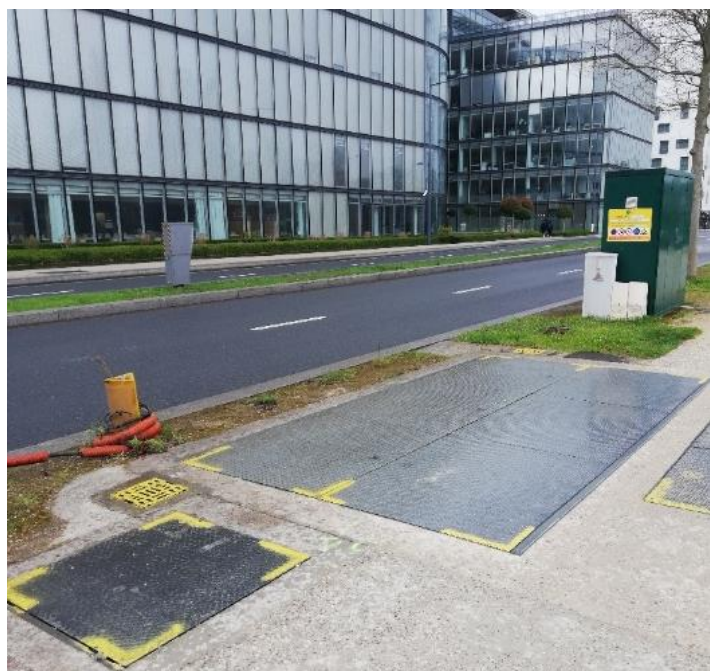
Poste enterré à Issy-les-Moulineaux © Christophe Perdrisot - DGSCGC
