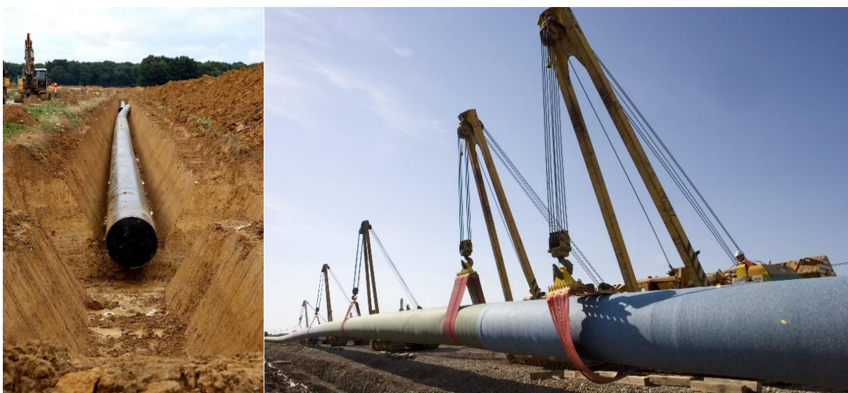
Pose du gazoduc Val-de-Saône et Fos Cavaou © GRTgaz
